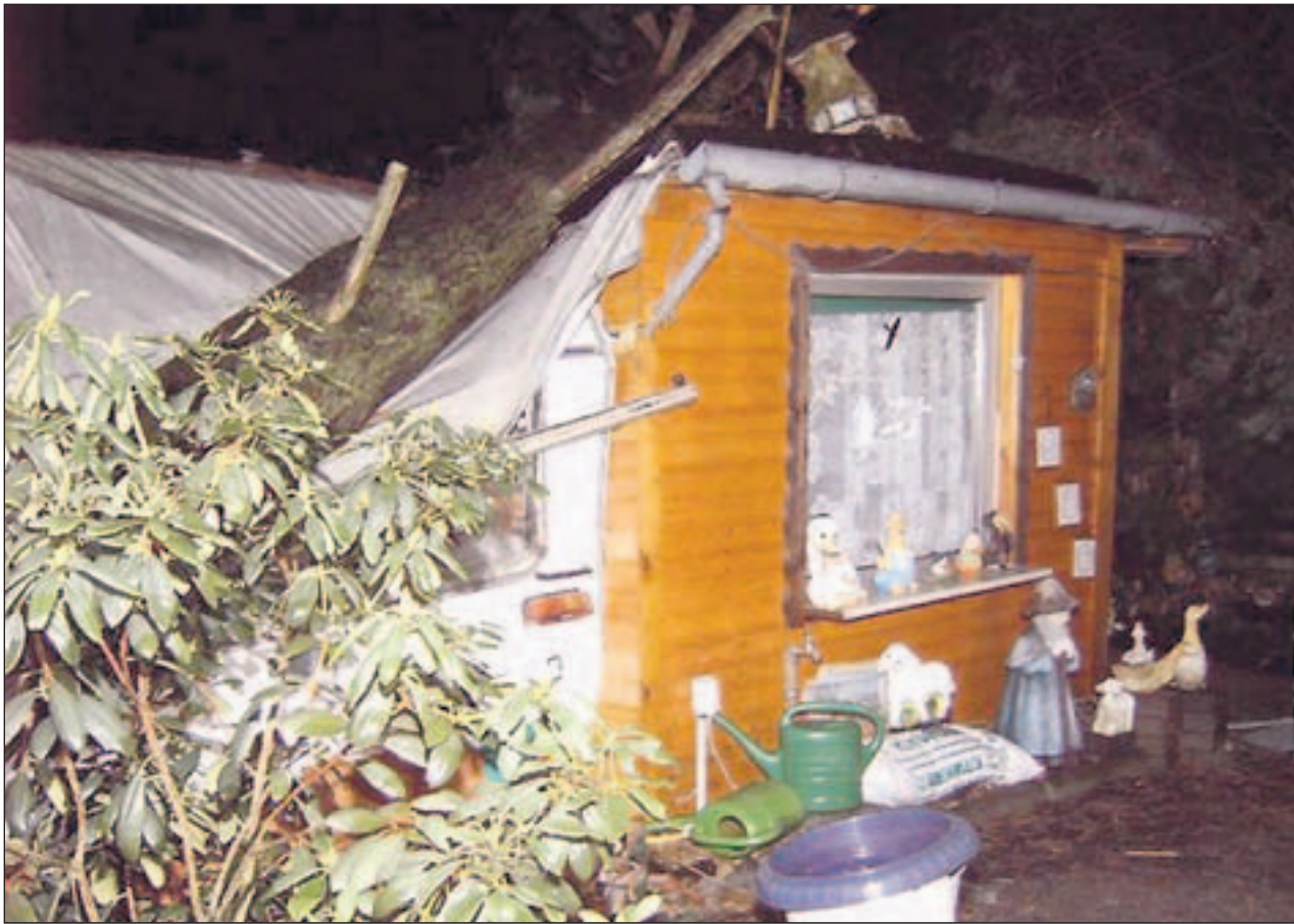
In der Ferienhaussiedlung „Pulschmoor“ am Erikasee stürzte ein Baum auf einen Campingwagen mit Vorbau. Die Besitzer blieben unverletzt.
