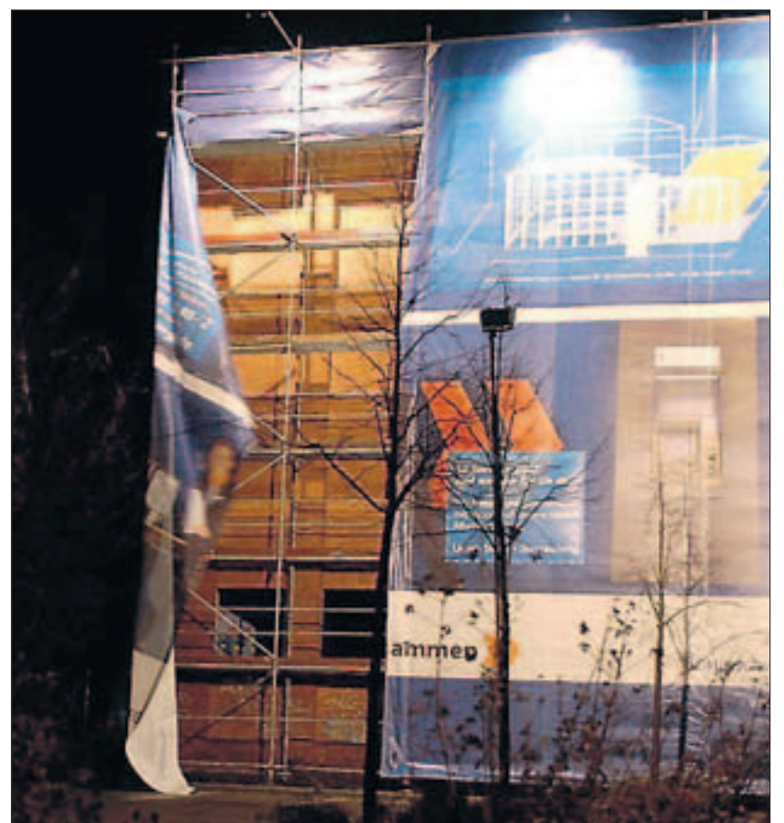
Am Kleinen Zuckerhaus in Meine riss der Sturm am Baugerüst die Schutzplane herunter.
