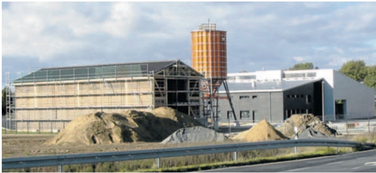
Das ist der neue Stützpunkt der Autobahnmeisterei Braunschweig an der Waller Auffahrt zur Autobahn A 2. Der noch eingerüstete Bau ist die neue Streuguthalle, daneben steht das Silo zur Befüllung der Streufahrzeuge. Foto: Franz
